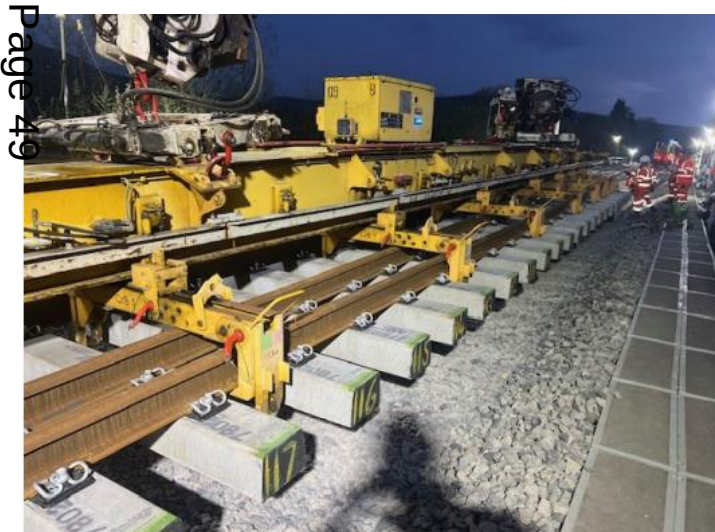
Uppermill Track Renewal 748m off-line tie-in)
